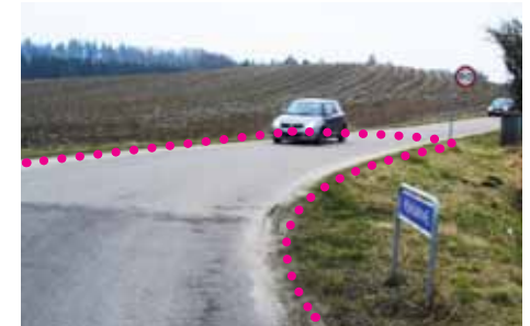
Overgang ca. 15 meter fra krydset giver øget overblik.
